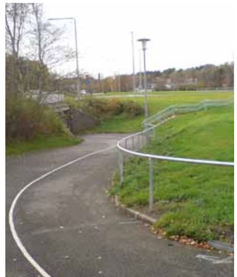
Komplettering av räcke vid gångväg till hållplats.
