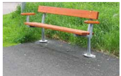
Anläggning av hårdgjord yta intill gångbana med utplacering av nya soffor.
